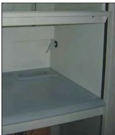
Tampo em grés contínuo da Keraplan com rebordo anti-derrame
